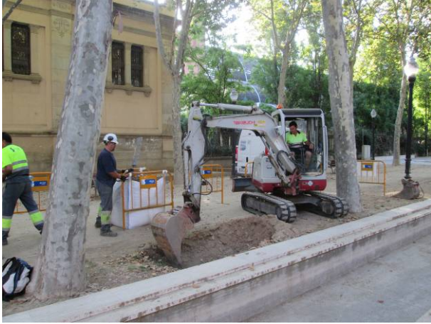
1. Inici de l'obertura de la rasa.
